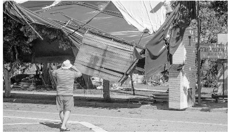
Desastre. Los fuertes vientos provocaron destrozos de todo tipo e incluso se cayó el techo de la terminal de ómnibus. - Télam -
