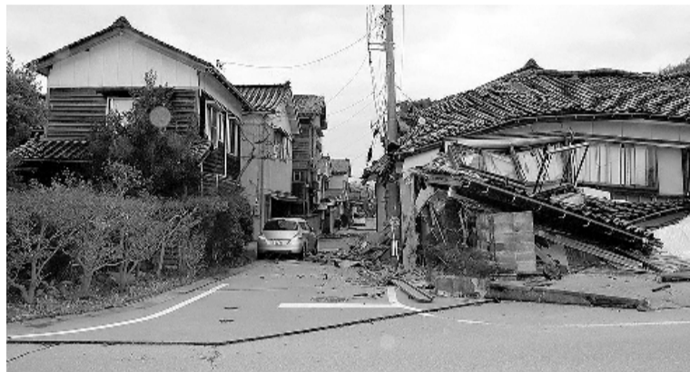
Movimiento. La vista general muestra edificios muy dañados a lo largo de una calle de la ciudad de Wajima. - Télam -
