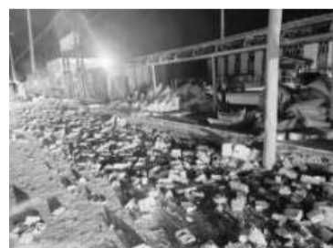
Colapsaron 47 edificios. - AFP -
