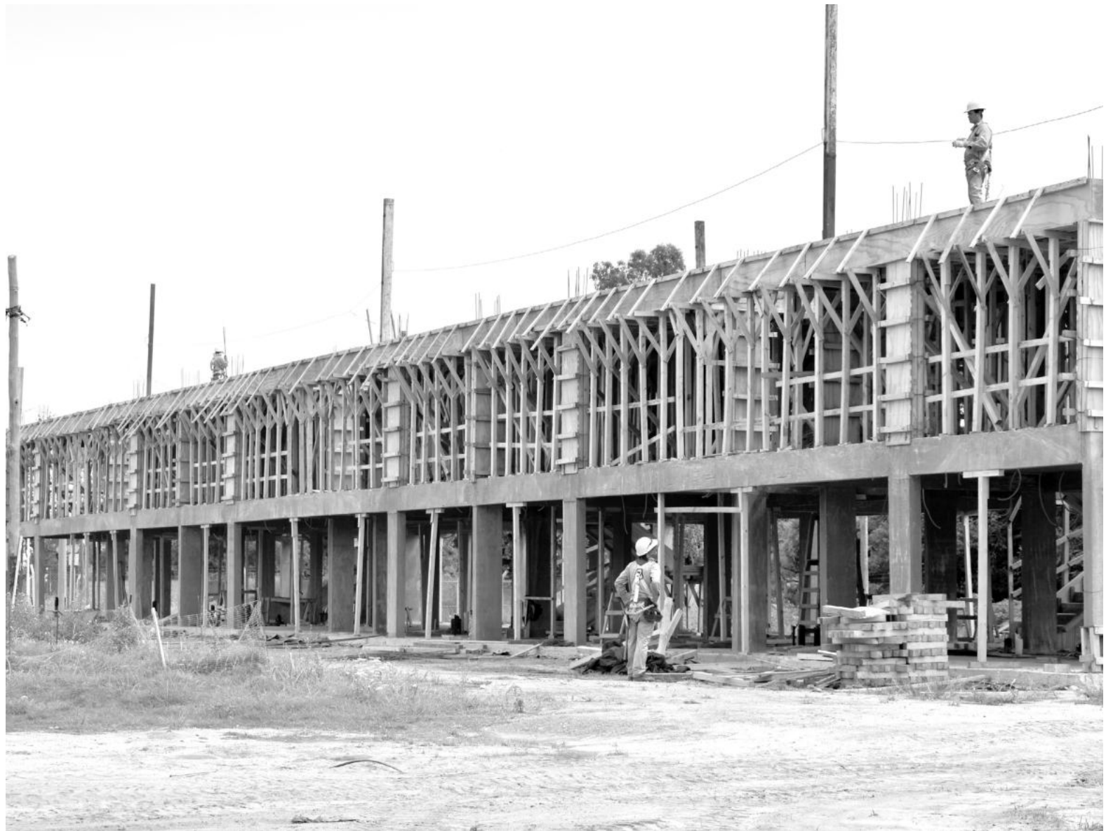
De acuerdo con los planes originales, la obra iniciada en mayo pasado tiene un plazo de ejecución de 12 meses. IARA CERASI / EL NORTE
